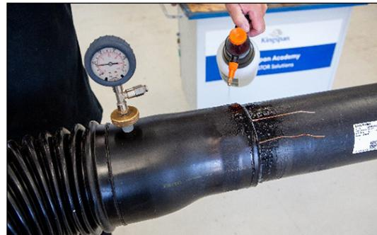
Wenn die Muffe kontrolliert worden ist und dicht ist, die Terminals an der Kante der Muffe abschneiden.
