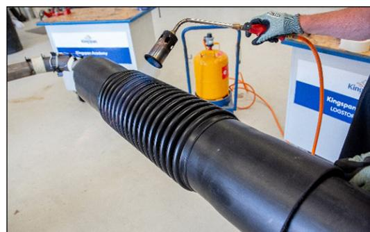
Fortsetzen bis der Balg so flexibel ist, dass er sich leicht manuell zusammendrücken lässt.
