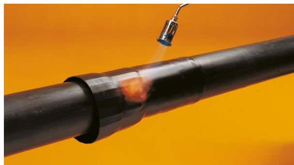
Termo-restrizione del tubolare BXJoint. Seconda tenuta.
