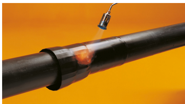
Podgrzewanie złącza BXSJoint. Drugie uszczelnienie
