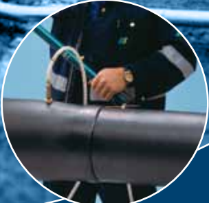
Dichtigkeitsprüfung vor dem Ausschäumen
