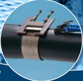
Die Schweißbausrüstung wird montiert
