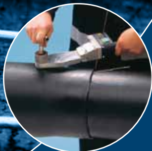
Montage und Verschweißen der Schweißstopfen
