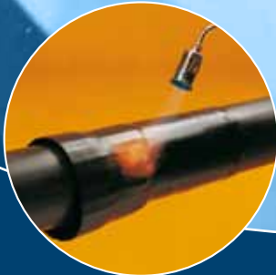
Schrumpfen der Muffe Zweites Abdichten
