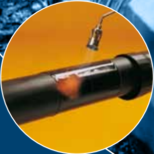
Aufschumpfen der Schrumpffolie Erstes Abdichten
