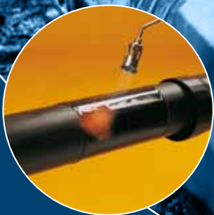
Aufschumpfen der Schrumpffolie Erstes Abdichten
